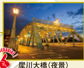
犀川大橋(夜景)
